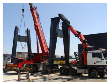
Aufstellen der beiden Portalstützen
