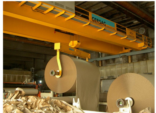
Der neue Kran in Betrieb.
