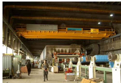
... der 40t Kran über der Kartonmaschine
