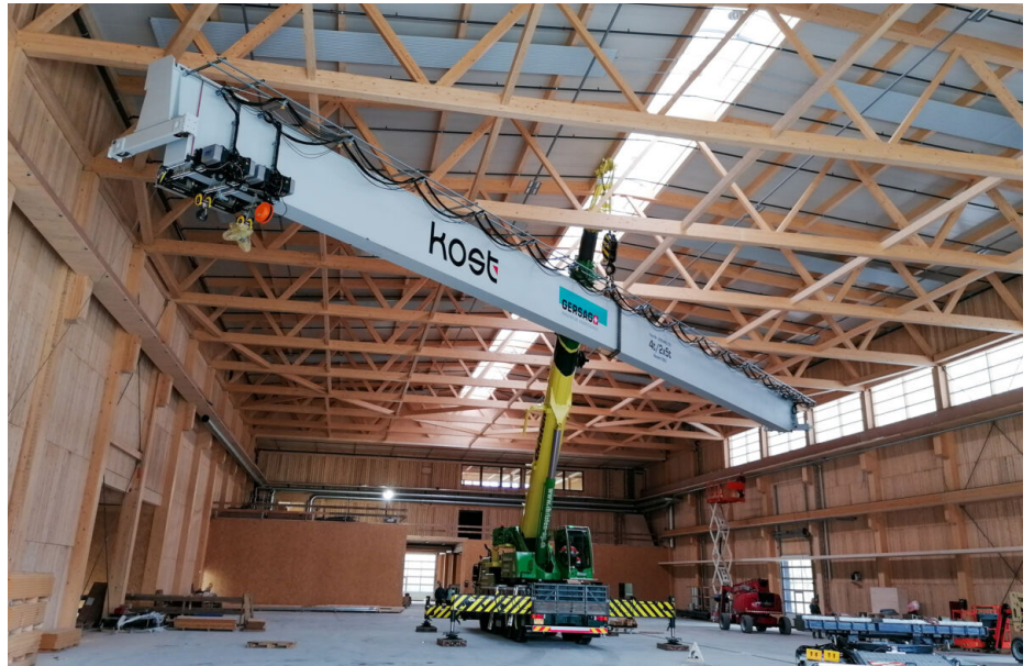
Aufbau des Einträger-Brückenkranes im April 2023.
